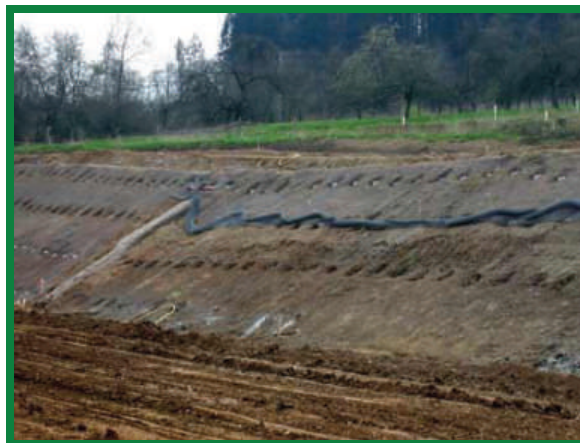
Поставување на мрежа за заштита од ерозија
